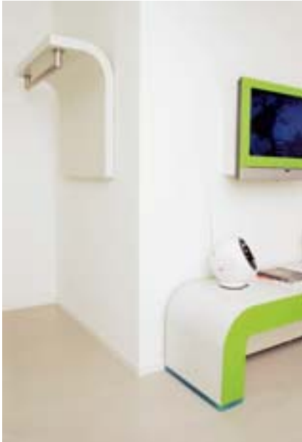
Garderobe: MDF-beplankter Kern aus FPY und Multiplex. Sideboard: Spantenbauweise
